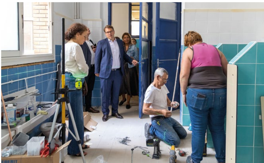
École maternelle Colonel Moll : Modernisation des sanitaires du rez-de-chaussée et des étages.
